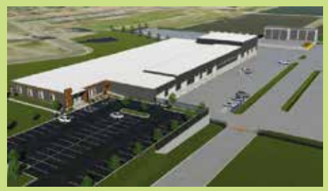
Construction des nouveaux ateliers municipaux avec panneaux à énergie solaire
