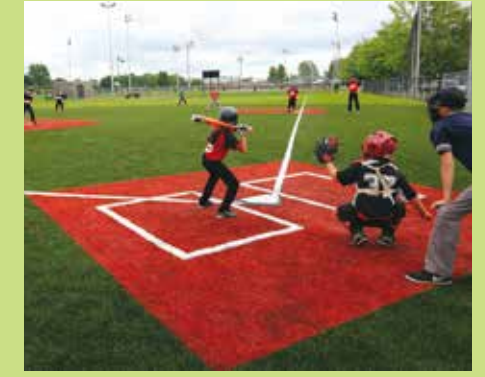
Construction d'un deuxième terrain de baseball synthétique avec granulat écologique
