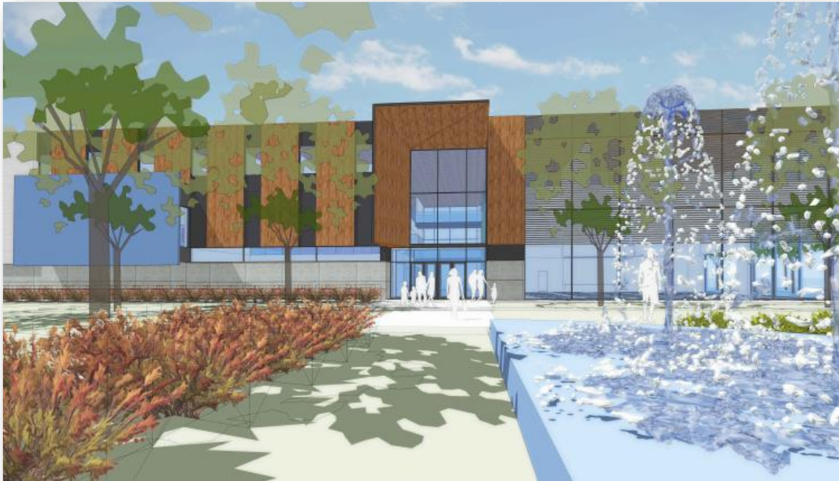
Construction du Centre multifonctionnel
