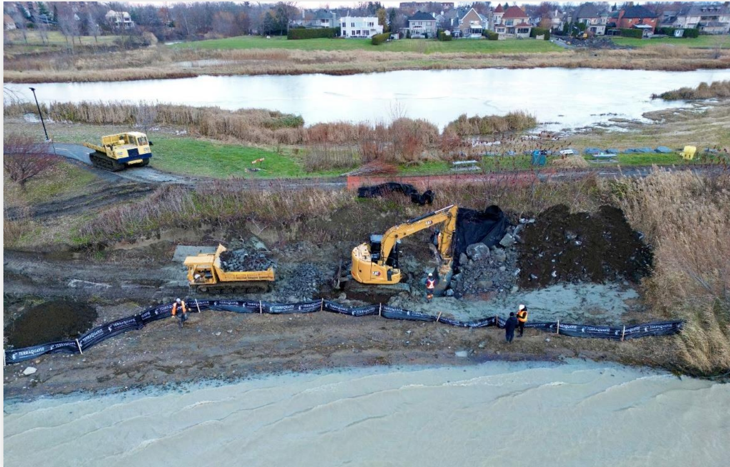
Travaux de stabilisation des berges
