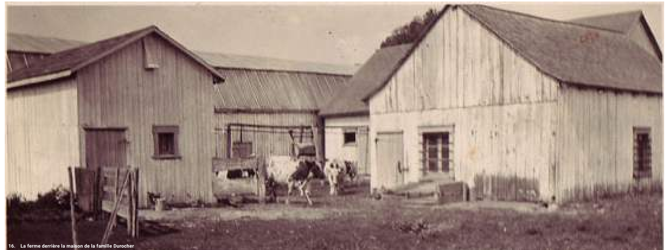
16. La ferme derrière la maison de la famille Durocher
